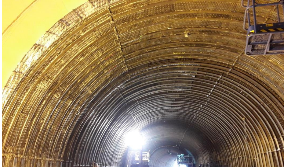
Ejecución de las obras de refuerzo estructural
