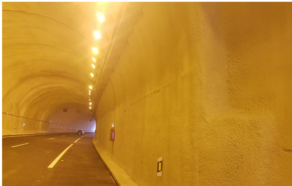
Tramo del túnel con el refuerzo estructural finalizado
